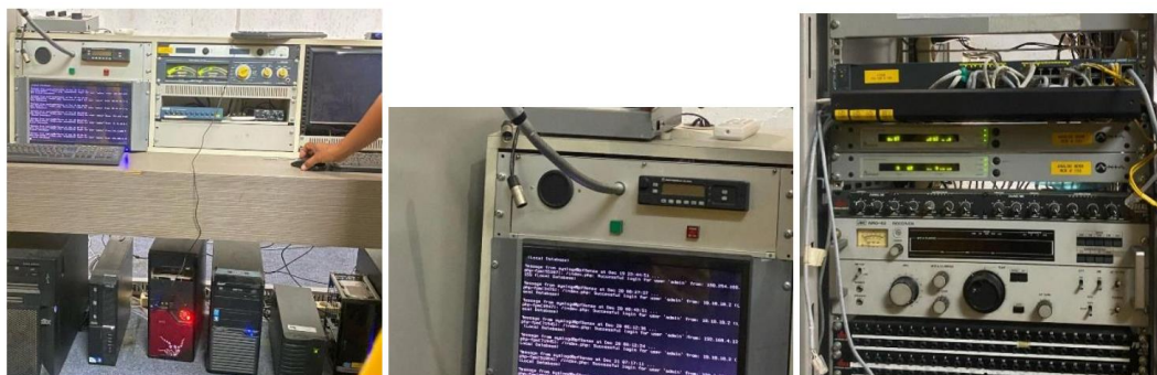
Gambar 3. Membantu perbaikan jaringan yang menghubungkan ruang MCR ke studio pro1, pro2 dan pro4
